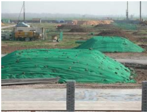
图 4.3-7 大临工程剥离表土苫盖
