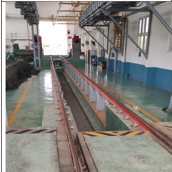
临修库作业线
