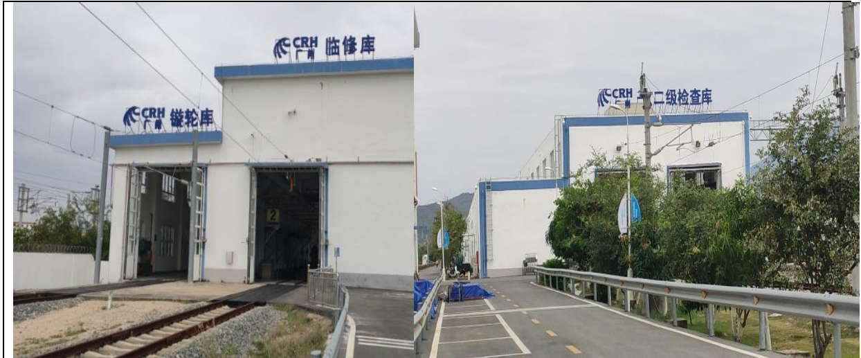
临修库、镟轮库
