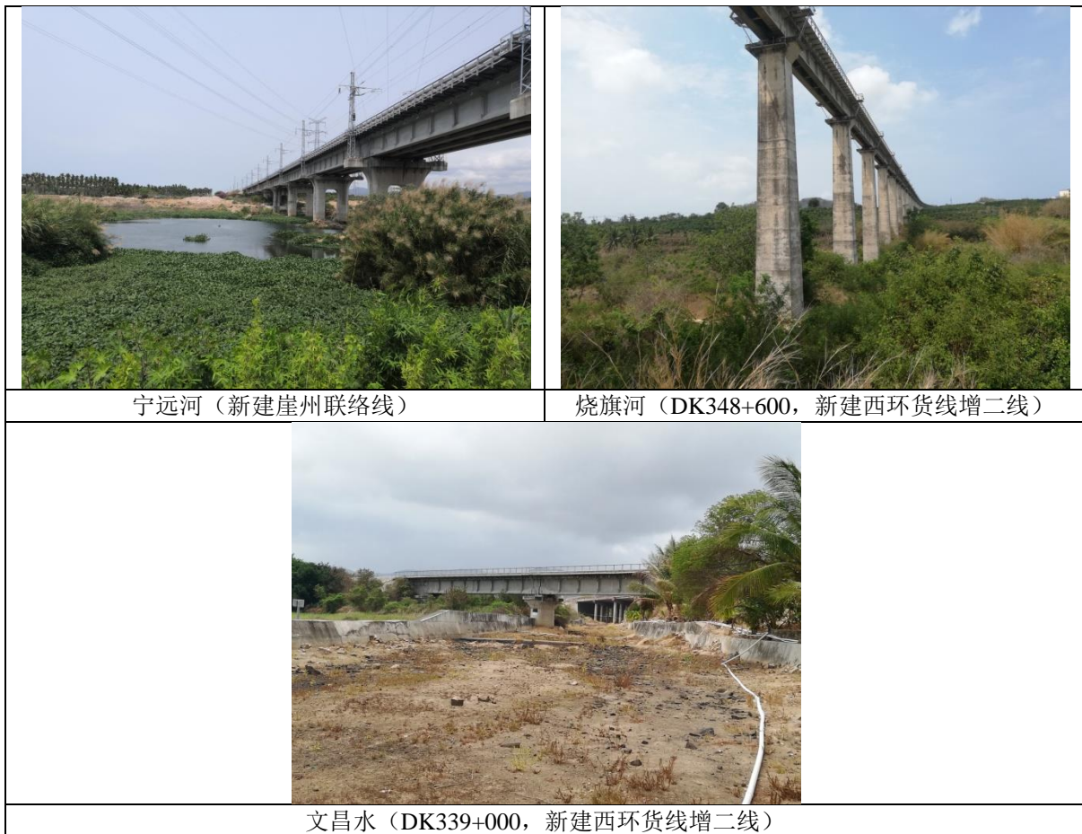
图 8.2-3 工程新建段跨越河流现状
