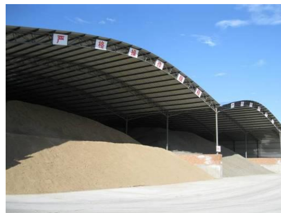
图 4.3-12 拌合站中砂、碎石密闭存放
